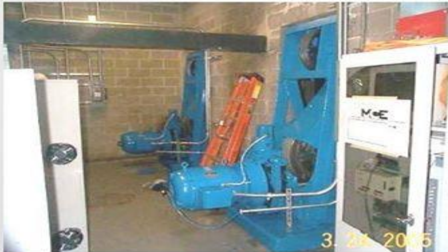
مواد تشطيب الارضية من مادة لا تسبب الانزلاق عزل جدران الماكينة والسقف ضد الضوضاء
