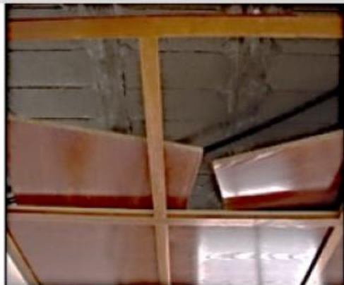
رفع الشبكة الخشبية و تركيب البلاطات الخشبية بها
