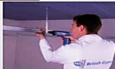
تركيب ال C channel بالتيش المعدني.
