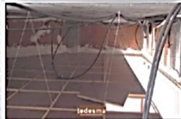
شكل التوصيلات فوق السقف الخشبي
