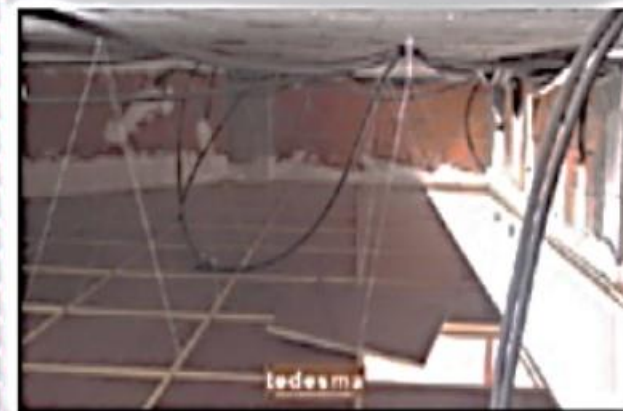
شكل التوصيلات فوق السقف الخشبي
