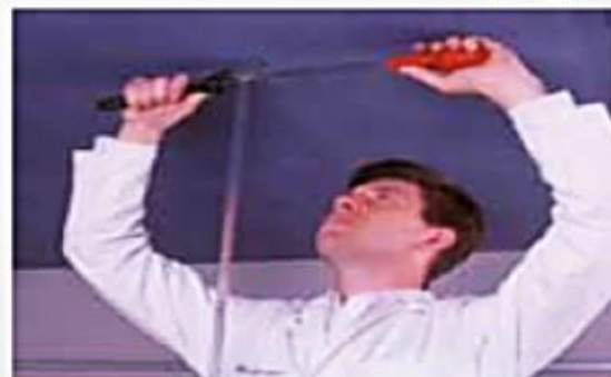
تركيب التيش الصلب في السقف.
