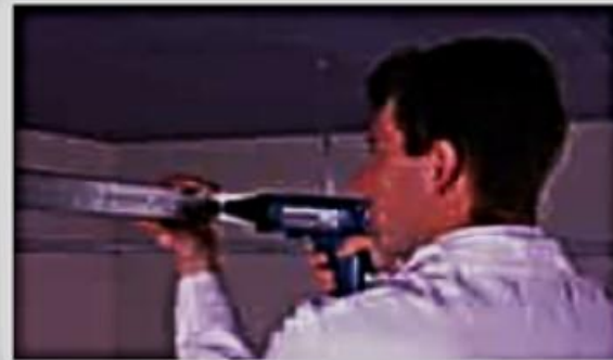
صورة توضح تركيب السقف المعلق
