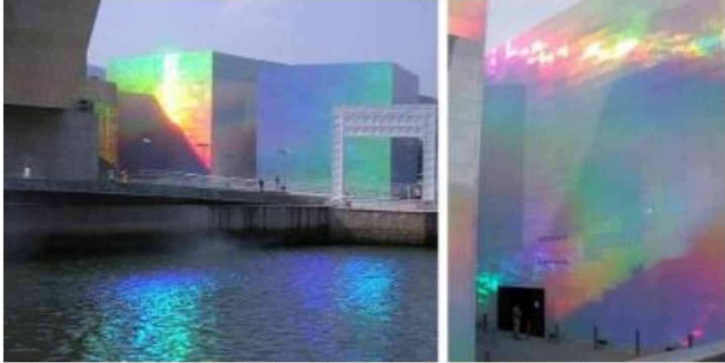
صورة رقم (٦) توضح استخدام بلاطات الهولوجرام في واجهات المباني مما يجعل السطح غنى بالاعمال الفنية والتجارب البصرية .
